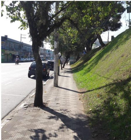
Figura 2: Calçada em região próxima à avenida Pref. Jonas Banks Leite, região central de Registro, em um dos poucos trechos arborizados do percurso. Neste caso, nota-se a dimensão reduzida do passeio
