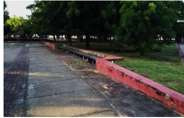
Banco em concreto (sem encosto) inserido no canteiro.
